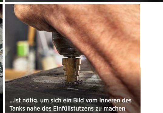
Innen fällt der bis auf kleine Löcher geschlossene Catch-Tank mit Saugleitung auf. Er muss zum Strahlen von außen angebohrt werden
